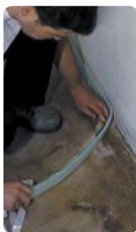
Inštalácia Uponor Minitec pásov na hranách
