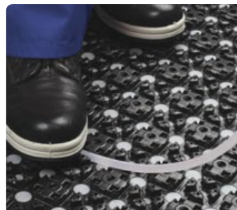
Uloženie rúrok zvláda jeden človek – úspora nákladov
