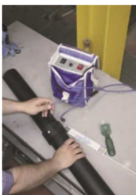
Pripojenie elektrozwáračky
