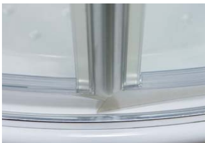
■ Prahová lišta a spodné tesnenie dverí
