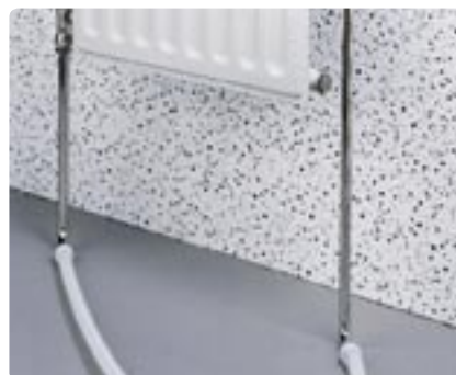
Inštalácia pomocou rozdeľovača
