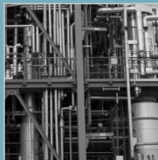
Výstavba chemických prevádzok a chladiacich systémov.
