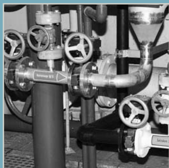
Inštalácia potrubí na prenos kyselín napr. v chemickom priemysle.
