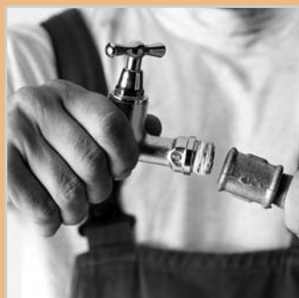
Utesnenie spojovacích závitov v konštrukcii klimatizačných zariadení.
