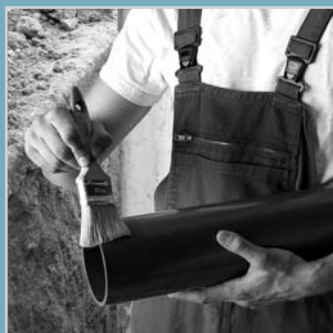
Lepidlo sa nanáša mäkkým maliarskym štetcom.
