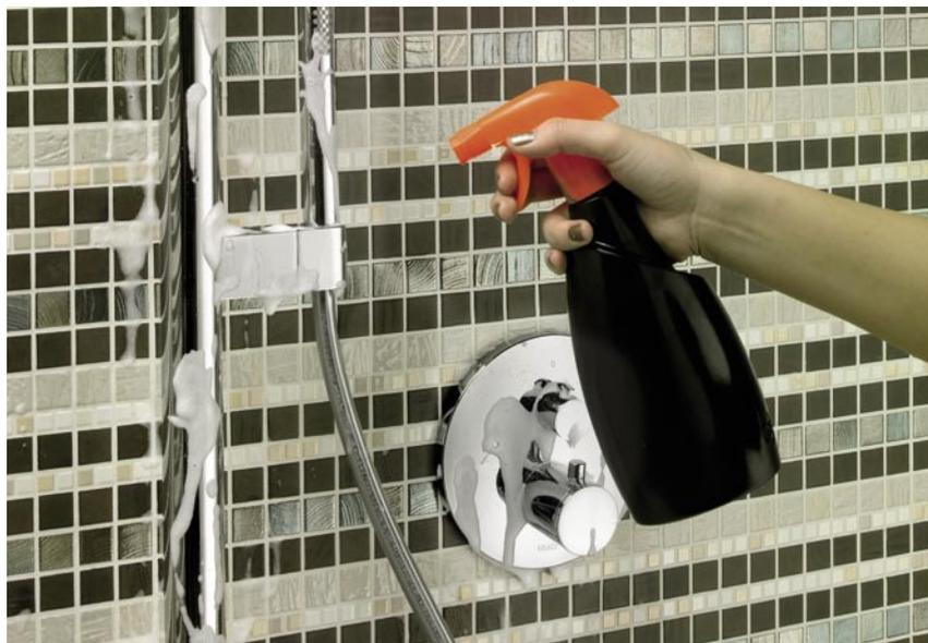
Silné čistiace prostriedky poškodzujú cementové škáry. PCI Geofug® pôsobeniu týchto výrobkov odoláva.
