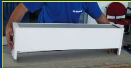
9. Nasazení hliníkového krytu
