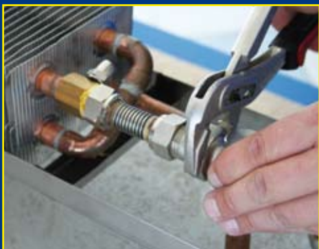
10. Montáž termostatické hlavice
