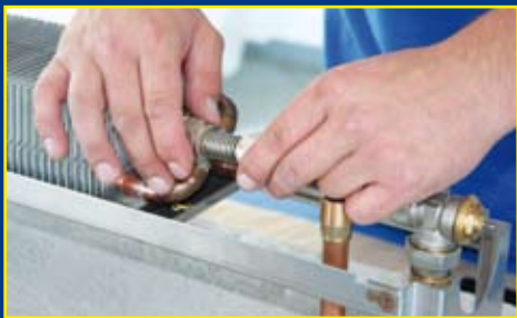
7. Montáž regulačního šroubení
