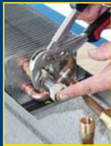
7. Montáž regulačního šroubení
