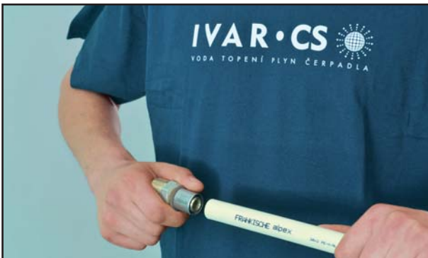
Vsunutie tvarovky IVAR.PRESS na odhrotovanú a skalibrovanú rúrku IVAR.ALPEX.
