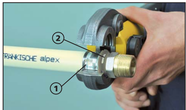
Pohľad na správne vykonanú lisovaciu operáciu potrubia IVAR.ALPEX s tvarovkou IVAR.PRESS
