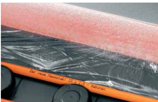
5d. Vloženie fólie okrajových oddeľovacích pásov pod okrajovú rúrku (nevyhnutné pri tekutých poteroch)
