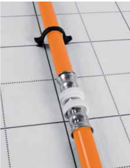
4. uloženie rúrky na systémovom páse
