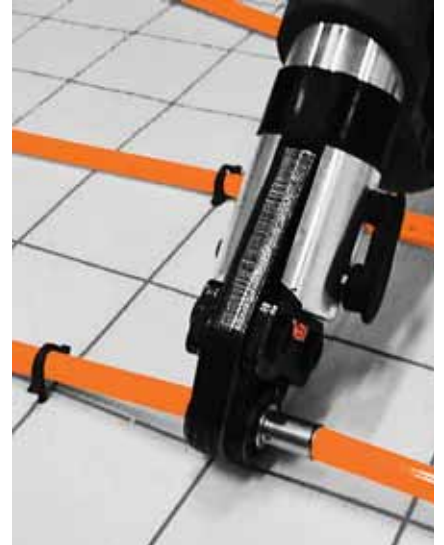
3. spájanie rúrok lisovaným spojom
