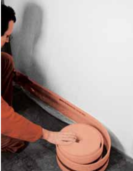
1. pokladanie okrajových oddeľovacích pásov
