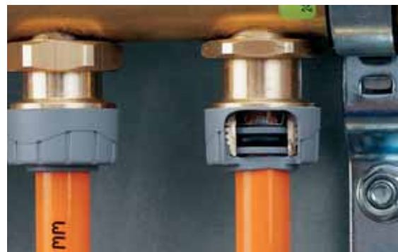
7. Rez hotovým spojím rúrky a zasúvacej spojky
