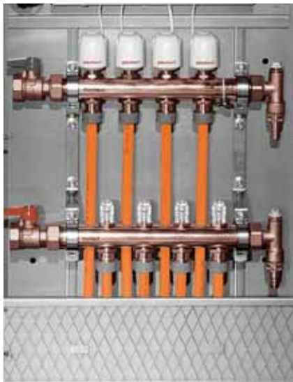
5. pripojenie rúrok k rozdeľovacej stanici
