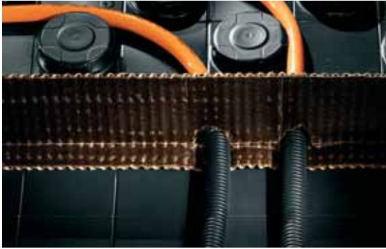
4b. Prívodná doska s dilatačným pásmom 1 m
