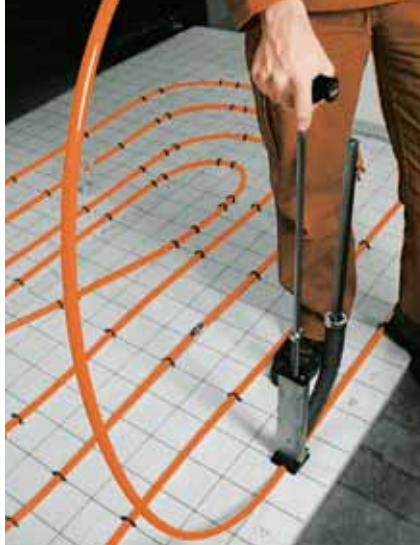
2. po položení systémových pásov špirálové ukladanie rúrky
