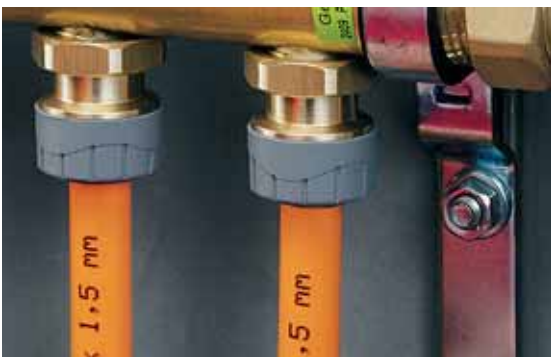
6e. Zasunutie konca rúrky do zasúvacej spojky a mierne povytiahnutie (spodná značka na rúrke je tesne pod spodnou hranou nasúvacej spojky)
