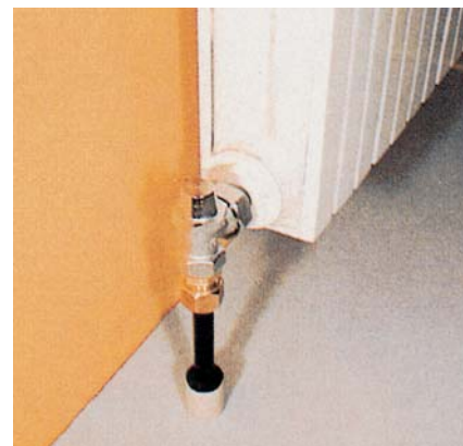
15. Vyústenie pripojenia vykurovacieho telesa z podlahy po položení cementového alebo anhydritového poteru.
