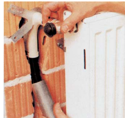
9. Pripojenie rúrky na vykurovacie teleso (na obr. cez axiálny ventil pomocou adaptéra) ochranným oblúkom pre pripojenie zo steny s možnosťou nastavenia dĺžky.
