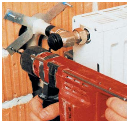
10. Upevnenie kotviaceho plechu ochranného oblúka pomocou skrutiek a hmoždiniek.
