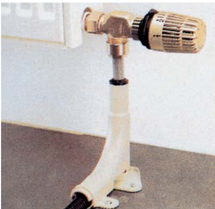
7. Pripojenie rúrky na vykurovacie teleso (na obr. cez axiálny ventil pomocou adaptéra) a pevné ukotvenie ochranného oblúka do podkladového betónu klincami alebo skrutkami a hmoždinkami.
