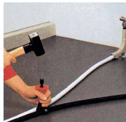
12. Upevnenie rúrok držiakmi rúrok GT-DS a GT-S na podkladový betón.
