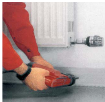
3. Do steny sa podľa otvorov v zadnej stene soklovej lišty vyvrtávajú otvory 6 mm pre hmoždinky vo vzdialenosti 50–75 cm od seba. Podľa druhu stavebného materiálu steny sa môžu použiť aj iné (bežne dostupné) skrutky a hmoždinky.
