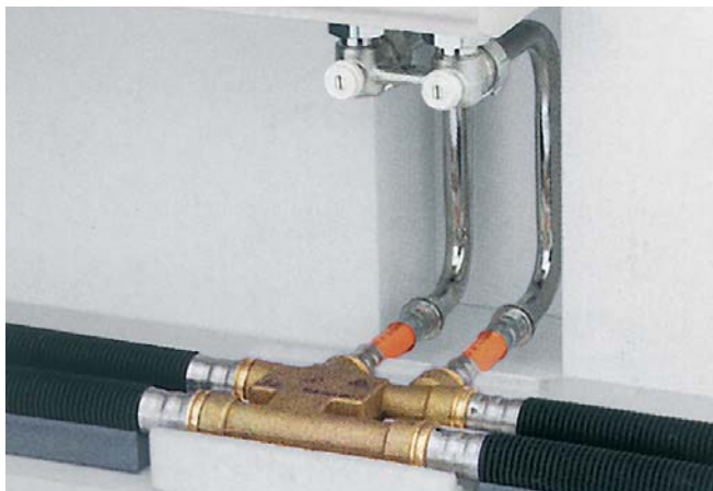
Ohýbané pripojenie vykurovacieho telesa.
