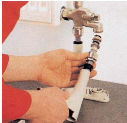
5. Nasunutie krúžku ochranného oblúka, ochranného oblúka GT-BV, krycej zátky GT-AS a jednotlivých častí adaptéra (prevlečnej matice, zvieracieho krúžku, ochranného krúžku, O-krúžku, nástrčnej časti adaptéra) na rúrku.
