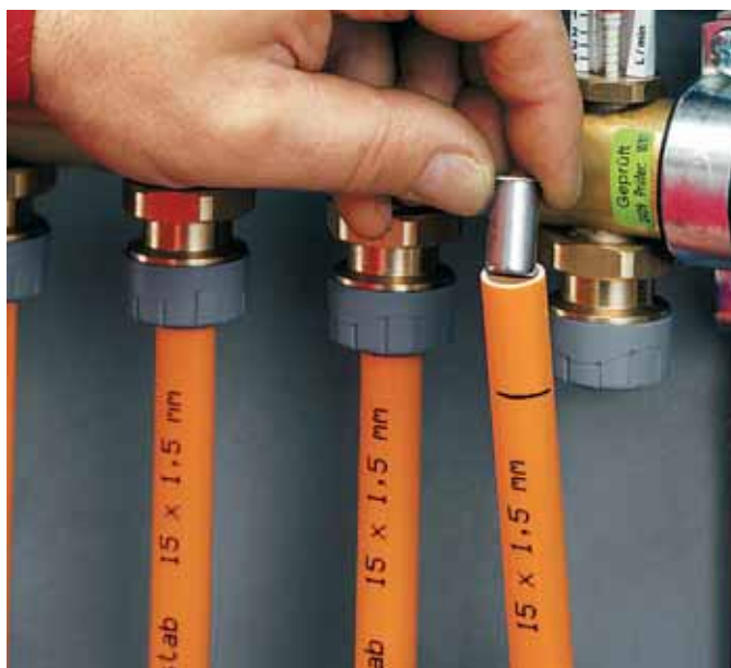
Rozdeľovač GTF-VSS so zasúvacími spojmi len pre rúrkou PB 15 x 1,5 mm
