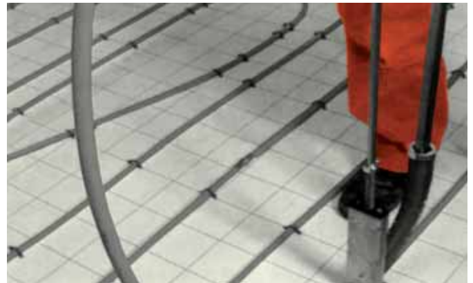
Rúrka sa upevňuje na systémový pás pomocou montážneho prístroja a kotviacich spôn.
