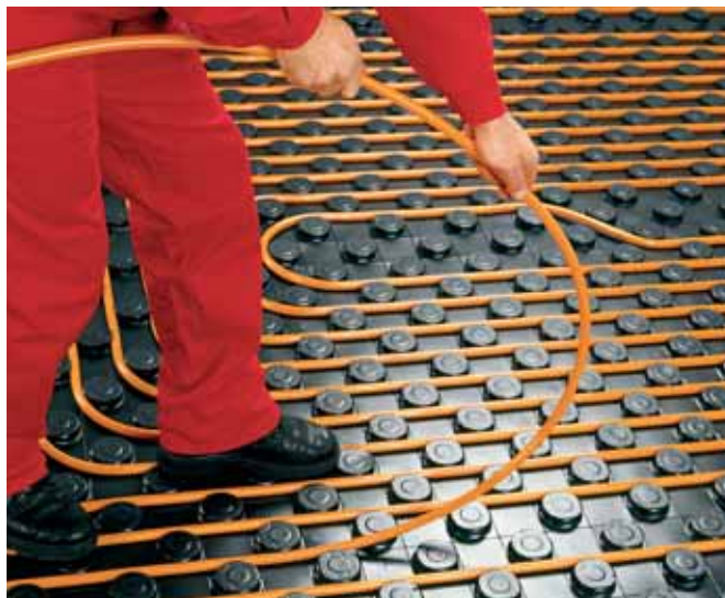
Do systémovej dosky sa môžu vkladať rúrky s rozmermi 15, 16, 17 a 18 mm vo vzdialenosti 75, 150, 225 a 300 mm, buď vo forme špirály alebo meander.
