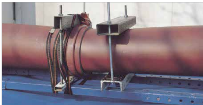
Zkouška těsnosti spoje (PP MASTER)
