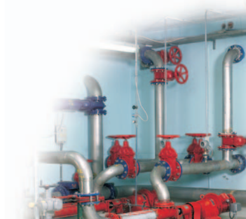
Séria 702 Nožový posúvač DN 50-1200 PN 10
