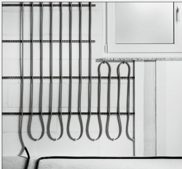
Mokrý systém vykurovania stien pre polybuténovú rúru
