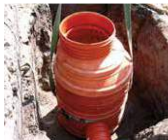
Šachta ve výkopu
