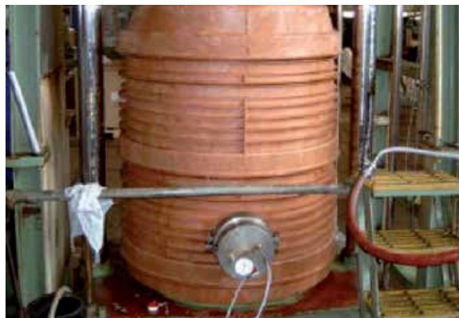
Přetlaková zkouška sestavy
