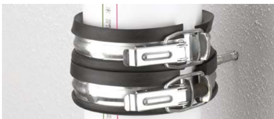
Obr. 05-6 Nainštalované podperné upevnenie
