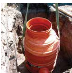
Šachta ve výkopu Obr. 15
