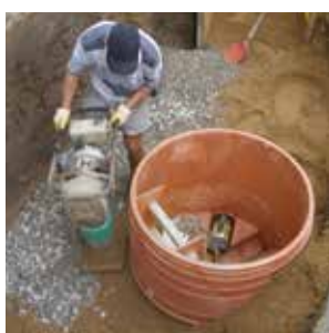
Hutnění zeminy Obr. 17
