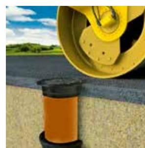
Instalace teleskopu Obr. 21
